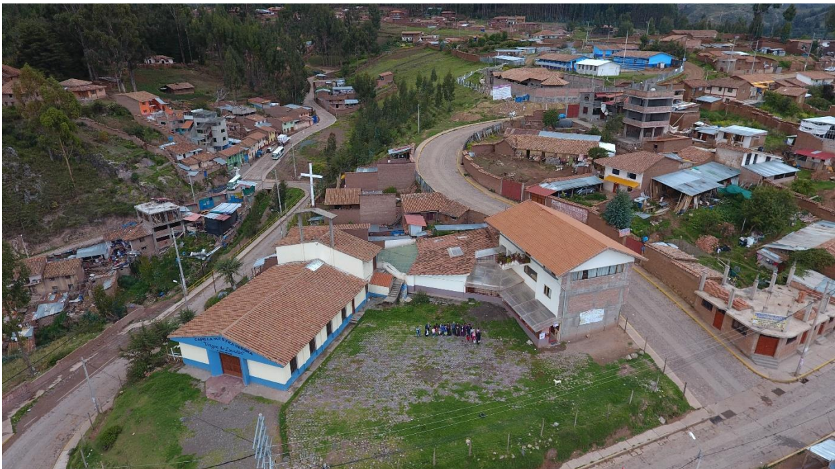
Anlage des Frauenhauses
